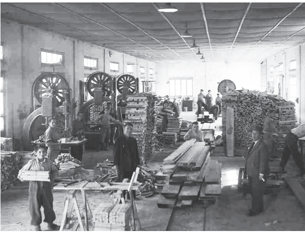
Interno della segheria di Bagnoli Irpino
