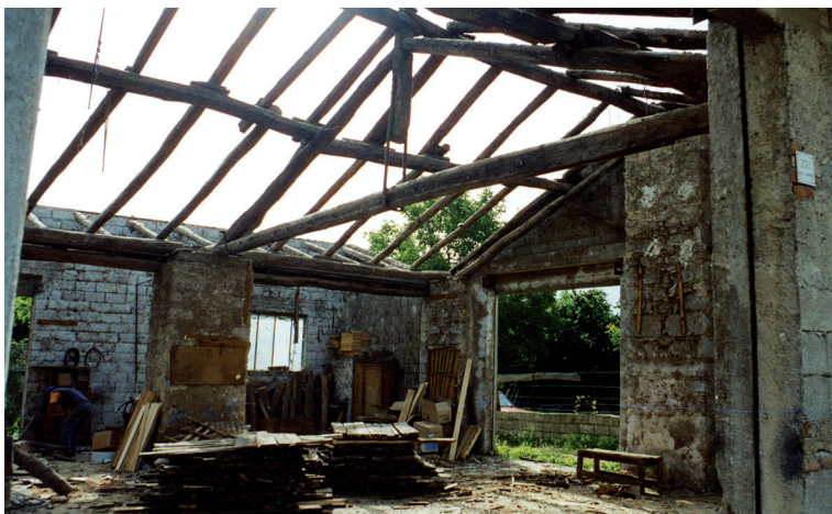
Demolizione dopo il terremoto dell'80
