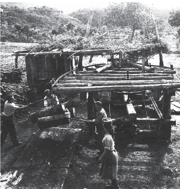
Stazione di partenza della teleferica in montagna
