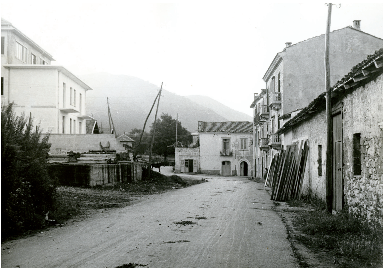
In alto: segheria Ziviello anni '60. Sotto: casa Ziviello prima del terremoto, a sinistra l'accesso alla segheria, sullo sfondo l'abitazione Fierro
