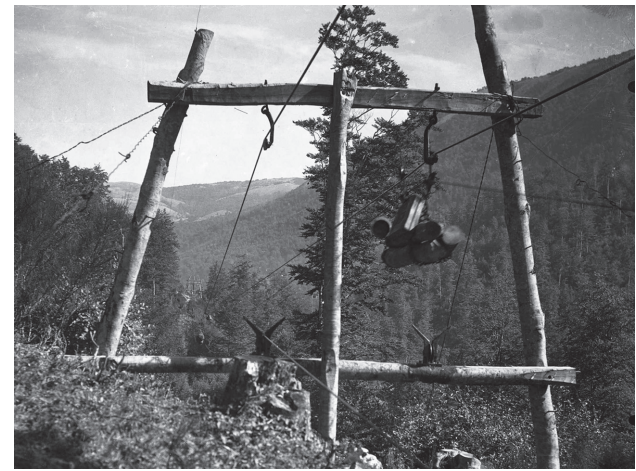
Cavi della teleferica con tronchi al passaggio di un "cavalletto"
