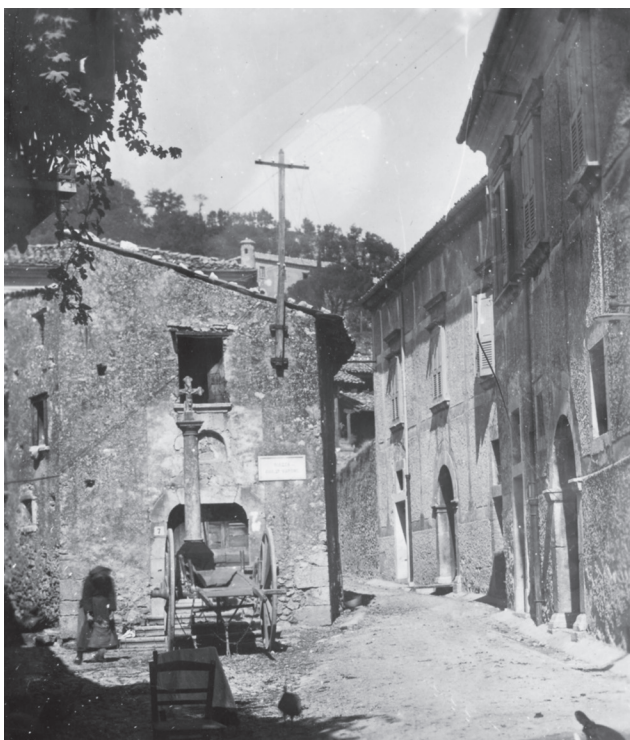
Piazza Giulio Capone prima e dopo le demolizioni di alcuni fabbricati. A destra la via di Verteglia in costruzione
