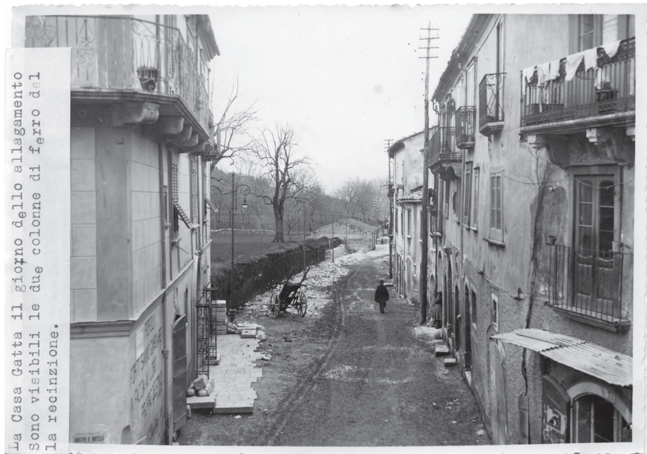
Foto 1. Questa strada, in origine larga poco più di due metri, ha avuto nel tempo varie denominazioni: Via Chianche vecchie, Via Domenico Ciociola, Via dell'Impero, e, finalmente... Via don Minzoni. Nella foto è visibile la recinzione cui si è fatto cenno nell'articolo; la rimozione, osteggiata dal proprietario, avvenne con la presenza dei carabinieri.
