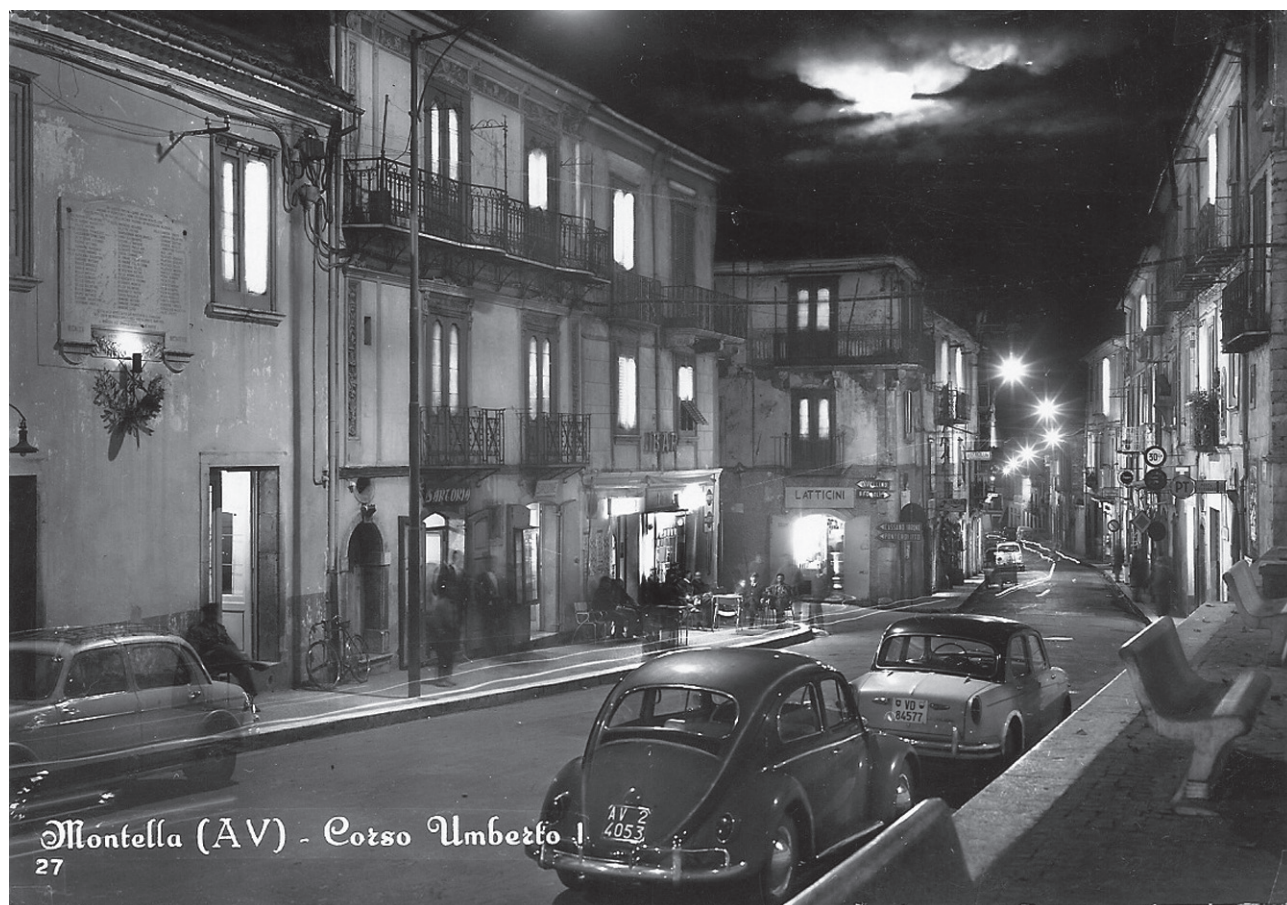
In questa foto sono visibili le lampade sospese a cordine in acciaio tese tra i fabbricati. Anni '60. (Da coll.ne Vinicio Sesso)
