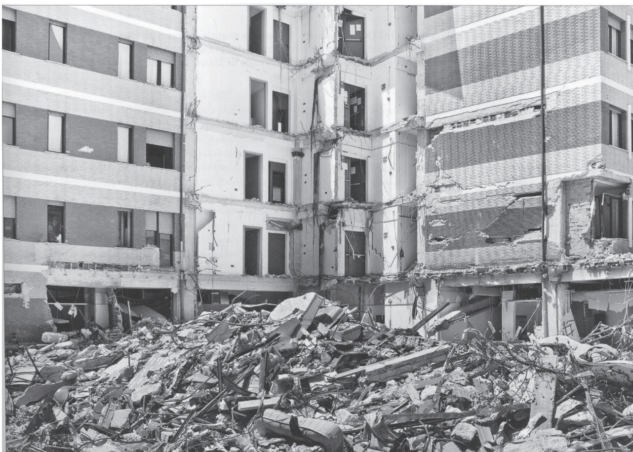
Le macerie della "Casa dello studente" in via XX Settembre a L'Aquila, sotto le quali sono morti otto ragazzi. Da: "L'Europeo" n. 10, ottobre 2010 . Foto Roberto Apostolo.
