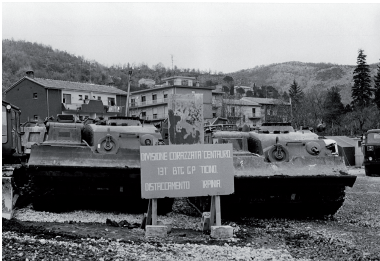
Montella, Piazza degli Irpini: due carri "disarmati" dell'esercito impegnati nella demolizione degli edifici danneggiati dal sisma - Foto Sica.
