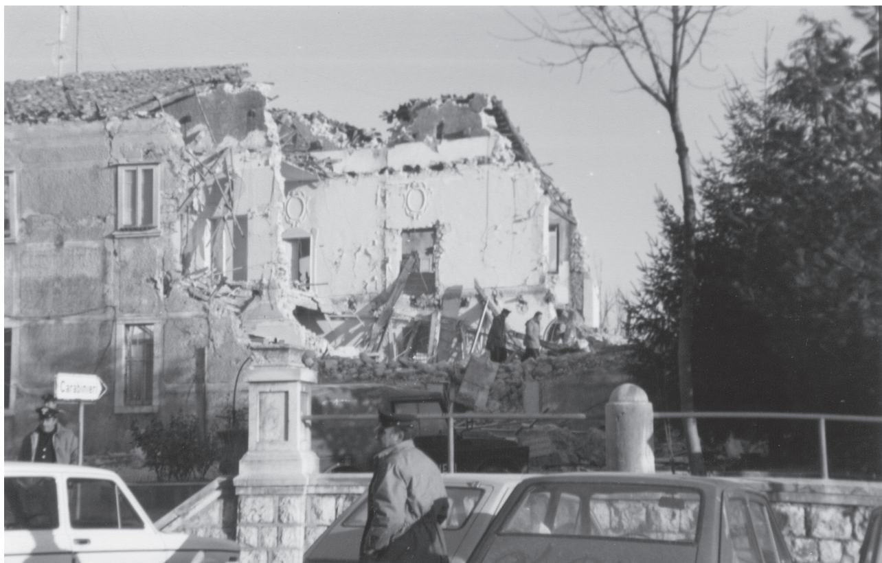
Montella, Largo dell'Ospizio: sono in corso i lavori di demolizione del fabbricato adibito a Caserma dei Carabinieri. Foto: Silvestro Volpe.
