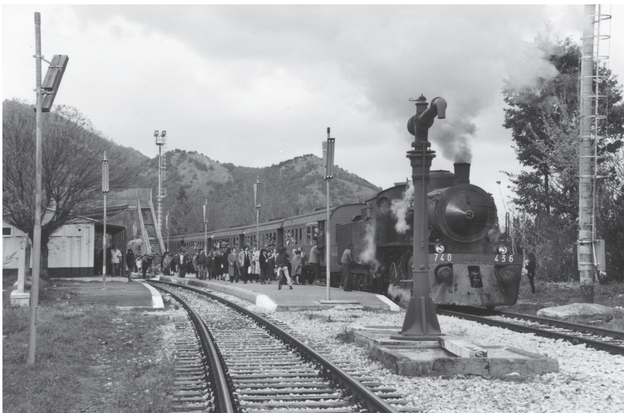
Stazione di Montella. In primo piano l'enorme giraffa per l'erogazione dell'acqua.
