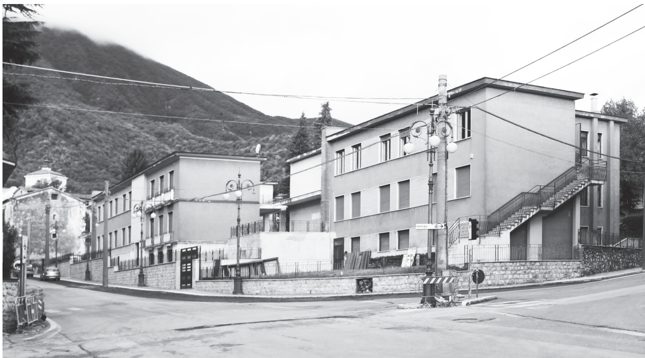
Via don Minzoni, Edificio Scolastico “Francesco Scandone” e sede dell’Istituto Comprensivo “Giovanni Palatucci”
