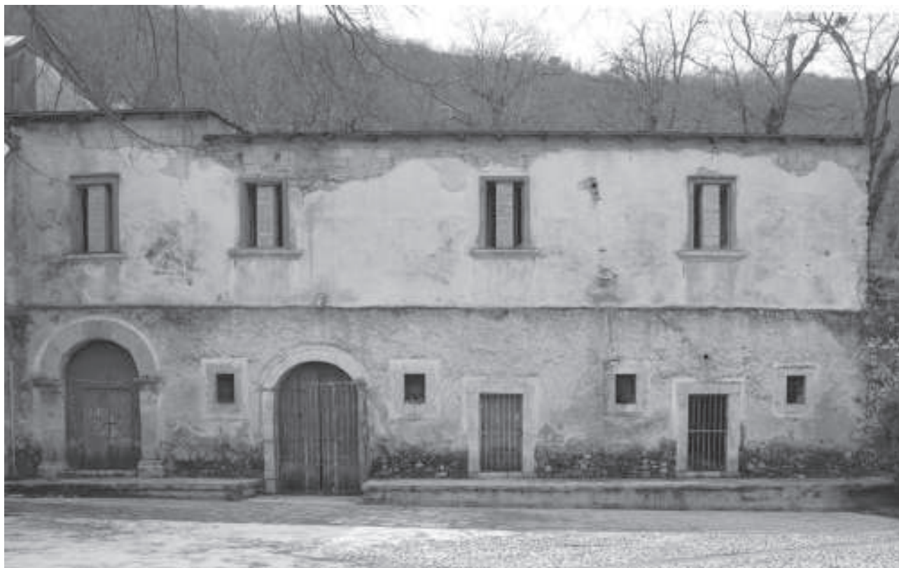
L'Ospizio edificato nel 1534 sotto la Camara .
