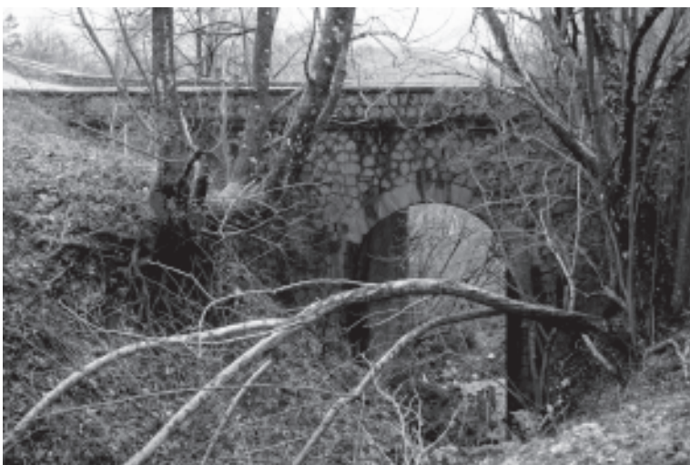
“... per poi imboccare come un fiume compatto il Vallone del Ponte dei Morti...”
