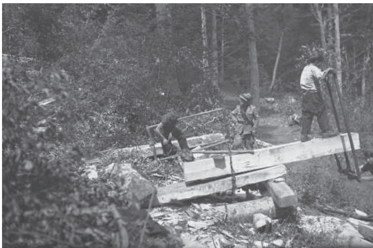
Bagnoli Irpino, lavori nel bosco. Foto Capozzi - Collezione Tobia Chieffo
